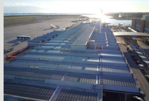
Dachanlage Venedig Flughafen
